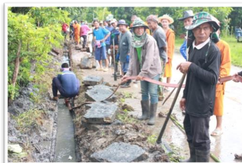
กิจกรรมการขุดลอกรางระบายน้ำอุดตัน
